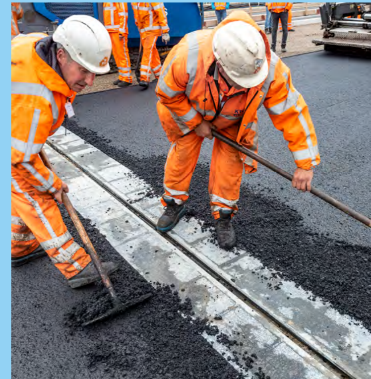
Voegwerkzaamheden op de Waalbrug
