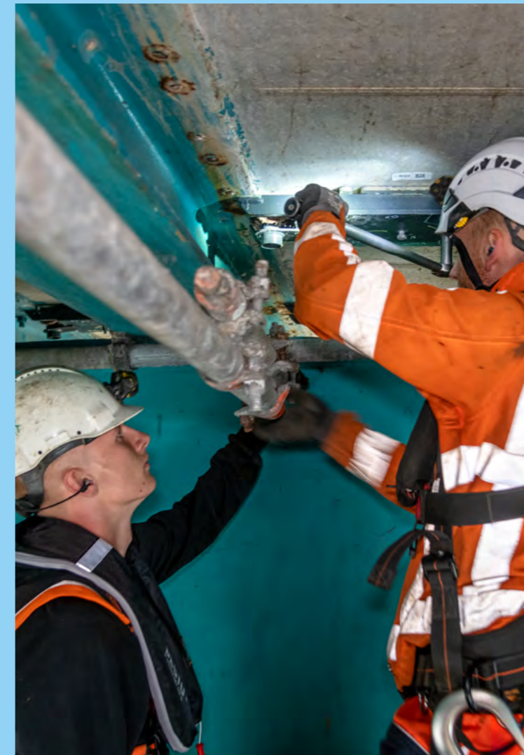
Onderhoud en inspectie aan Haringvlietbrug
