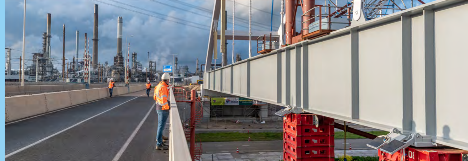
Plaatsing van de tijdelijke Suurhoffbrug in de A15
