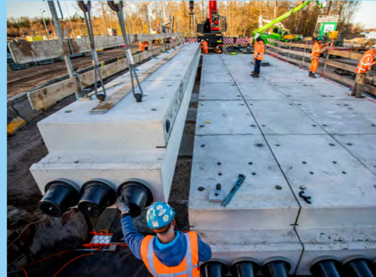
Prefab liggers van het circulair viaduct. Het gebruik van prefab liggers zorgt op de lange termijn voor CO 2 -besparing
